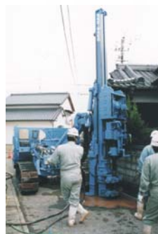
住宅街での工事
