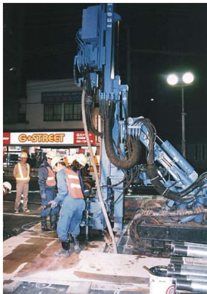
福岡市営地下鉄工事
