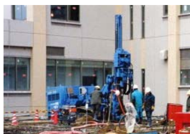
地中熱抽出井掘削工事
